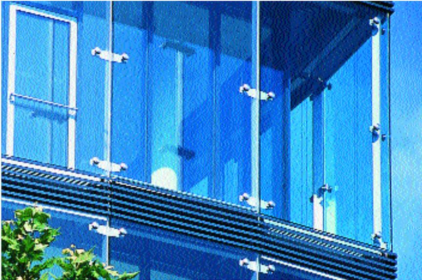
■ SWISSWALL: Ein Fassadensystem mit speziell von Glas Trösch entwickelten Punkthaltern für die Gestaltung rahmenloser Glasfassaden. SWISSWALL eignet sich sowohl für Einfachverglasungen in Einscheibensicherheitsglas oder Verbundsicherheitsglas als auch für Isolierglas.
